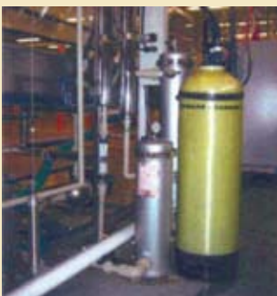
Mikroorganismen werden mithilfe eines ausgeklügelten Kohle- und UV-Filtersystems beseitigt.
